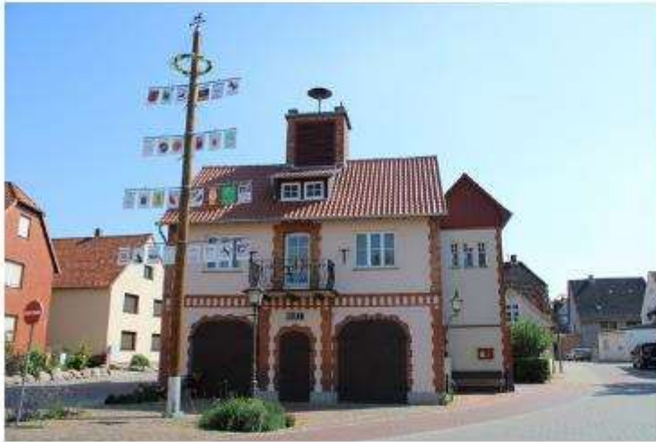
Umbau des alten 'Spritzenhius' in Lengede
